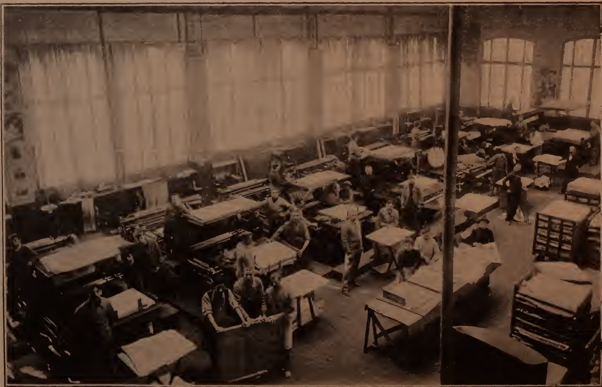
Vue générale d'une salle de machines lithographiques (entièrement conduite par l'électricité).
